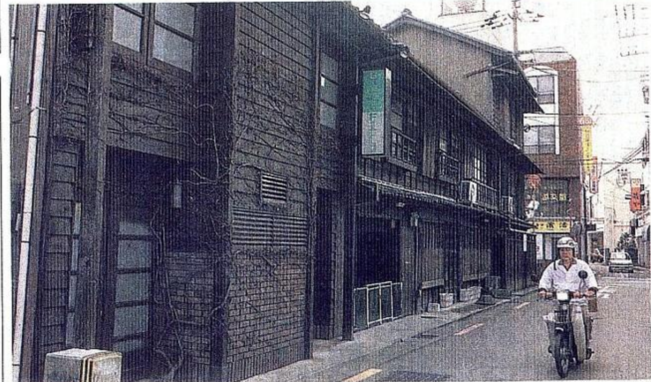
長屋を思い起こさせるような北面の長い外観。2階部分は戦後、徳島大学医学生の下宿部屋として使われていた面影を残している
