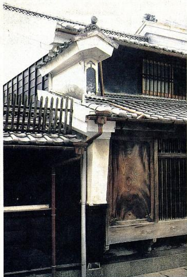
斜めに傾く1階の袖壁は池田の町家の特徴
