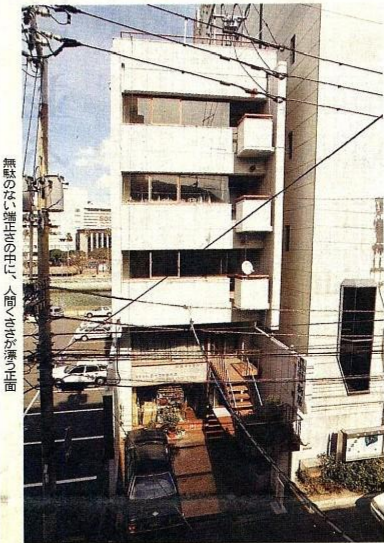
採光、通風を確保するため、北側壁面の3～5階は吹きさらし空間となっている
