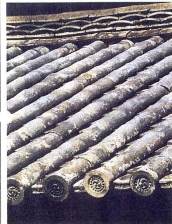
火伏せを願い、棟に青海波(波模様)を用いた本瓦ぶき屋根
