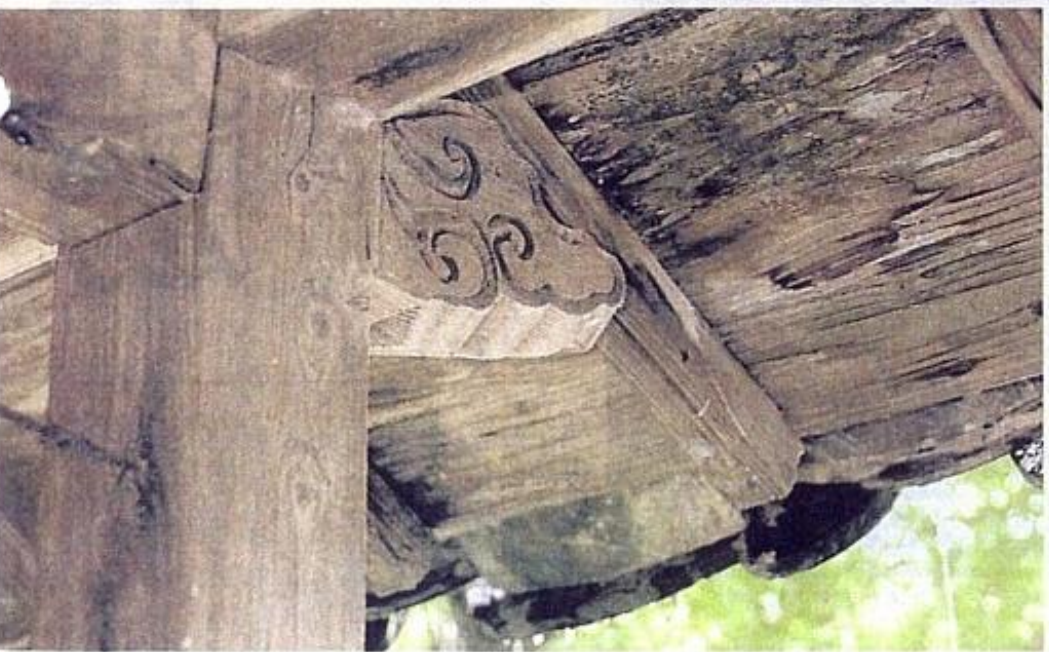
控え柱の柱頭部に付く木鼻。うず状の彫刻が、江戸時代の様式を顕著に表している
