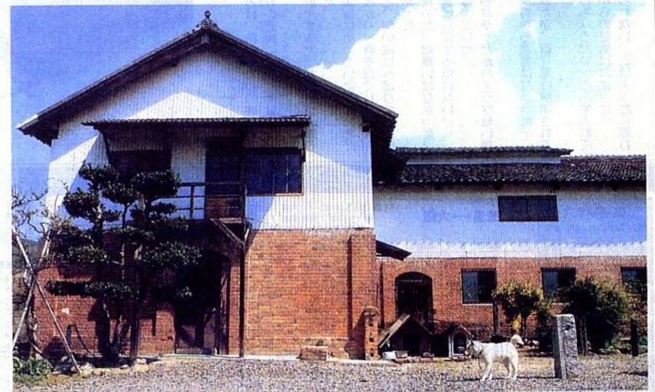
1階はれんが造り、2階は木造。れんがと白壁のコントラストが美しい
